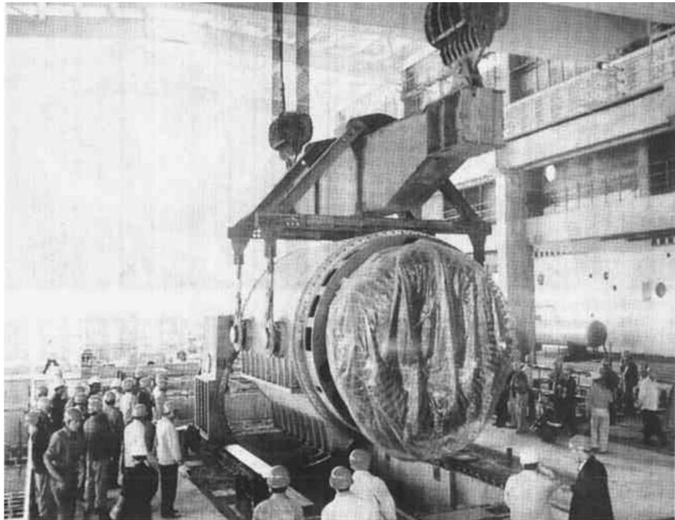
胜利发电厂二期工程3号发电机组近日由山东电建三公司顺利吊装就位。该公司为了吊装任务的顺利完成，克服了人员不足、设备到货不及时等困难，组织技术人员提前制定详细的汽轮发电机本体安装施工计划，为吊装工作的顺利进行奠定了基础。图为吊装就位施工现场。（杨志华 宋志国 摄）
